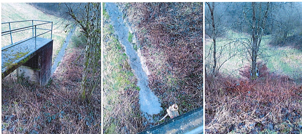
Fotos (von links): Blick vom Damm zum Mönchbauwerk mit Notüberlauföffnung sowie Becken mit Autobahndamm im Hintergrund, Schieber am Mönchbauwerk, Blick auf Auslauf und Tosbecken
