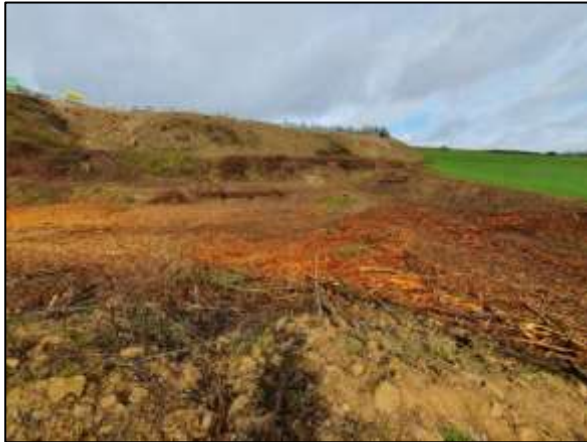
Blick von unten Rtg. Parkplatzaufschüttung
