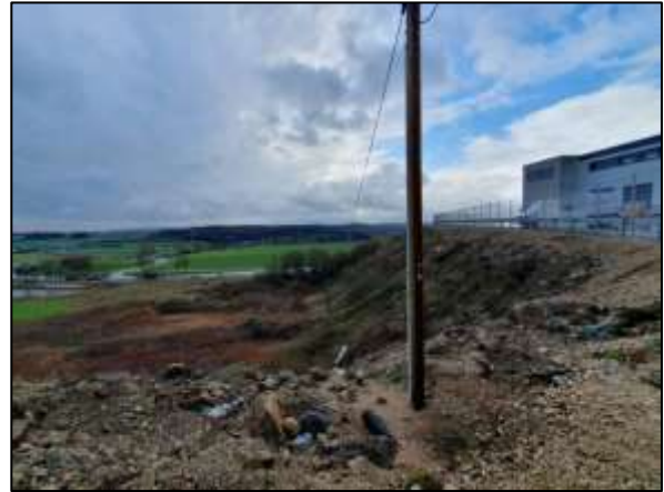
Auftragsbereich (Blick von oben auf B410)
