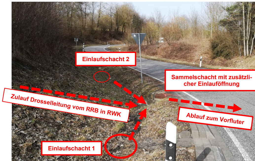
Anbindung Drosselleitung und Einlaufschächte an Einlaufschacht Straßenentwässerungskanal
