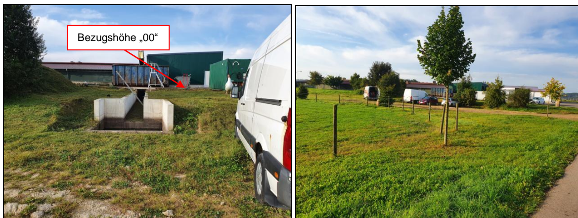
Fotos 1 und 2: Situation Baufeld am 14.09.2021
