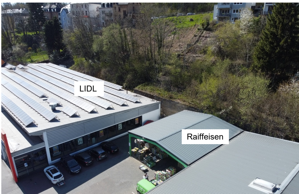
Hangbereich hinter den Gebäuden, nördlicher Grundstücksbereich / Blick nach Nordwesten
