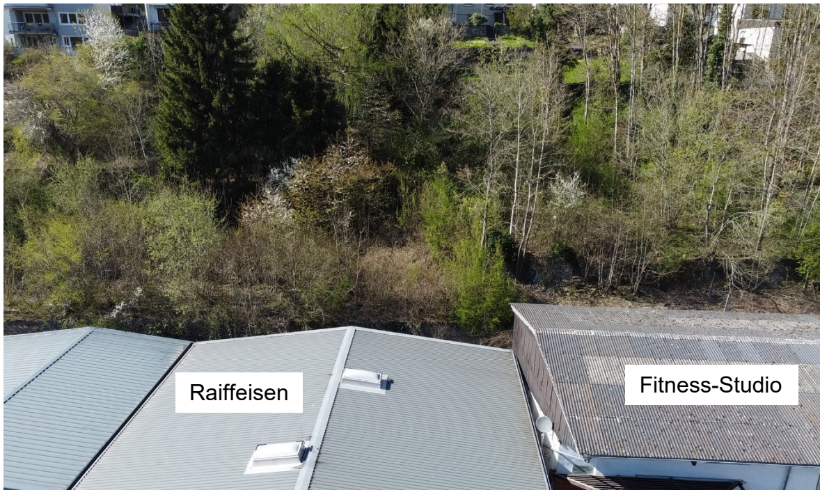
Hangbereich hinter den Gebäuden, nördlicher Grundstücksbereich / Blick nach Nordwesten
